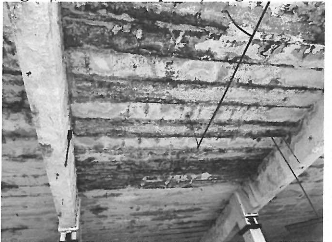
Elemente de acoperiș prefabricate tip FP degradate, fisuri pe două direcții, beton explodat datorită ciclurilor îngheț-dezghet, armături expuse și ruginite
