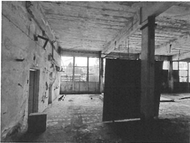
Stâlp central degradat la bază
