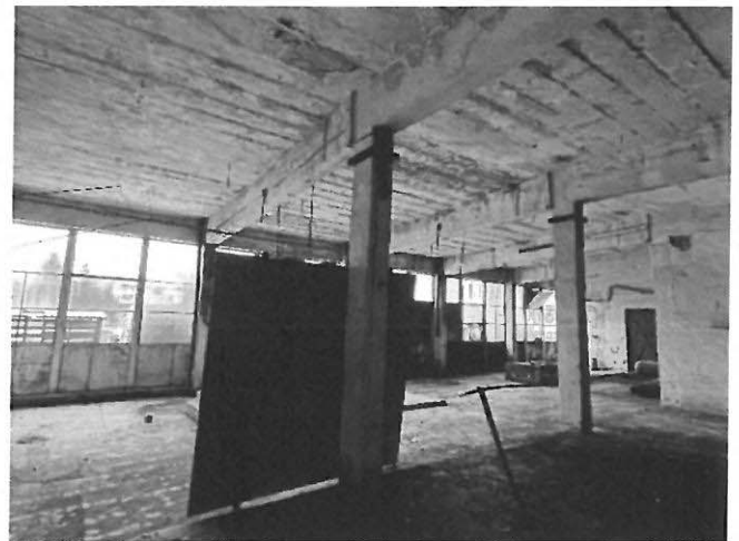
Stâlp central degradat la bază
