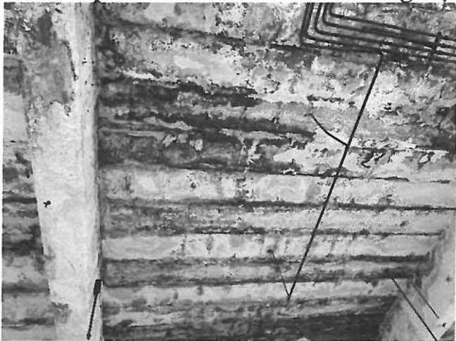
Elemente de acoperiș prefabricate tip FP degradate, fisuri pe două direcții, beton explodat datorită ciclurilor îngheț-dezghet, armături expuse și ruginite
