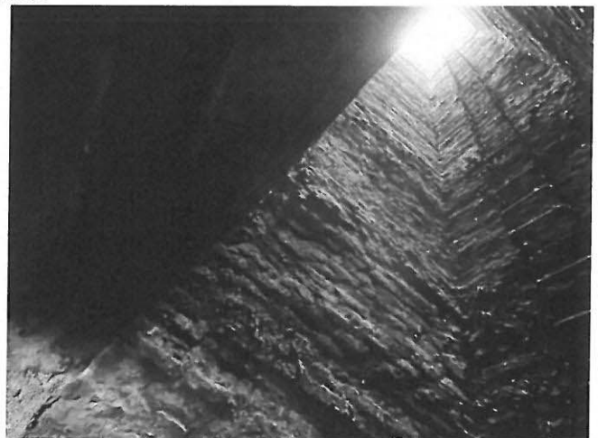
Infiltrații de apă prin coșurile de fum, cărămizi explodate, tencuieli desprinse, căzute
