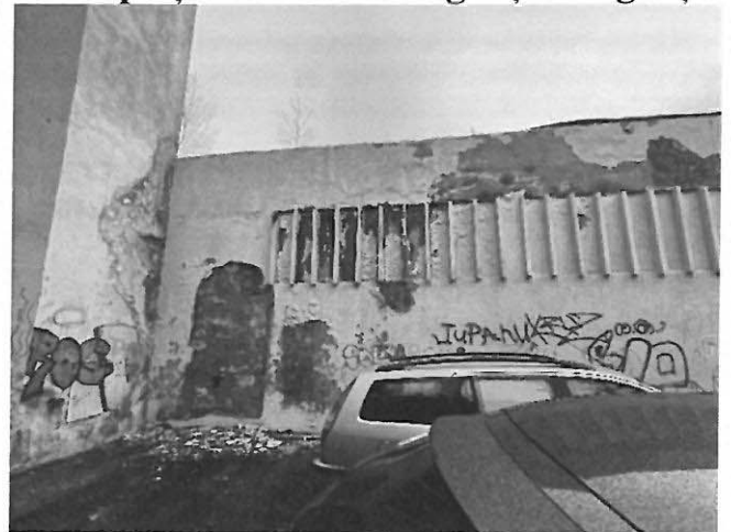
Tencuieli degradate, desprinse și căzute datorită infiltrațiilor de apă
