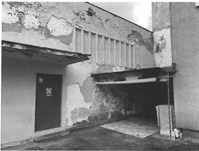
Elemente de acoperiș prefabricate tip FP deteriorate de infiltrațiile de apă și ciclurile îngheț-dezghet
