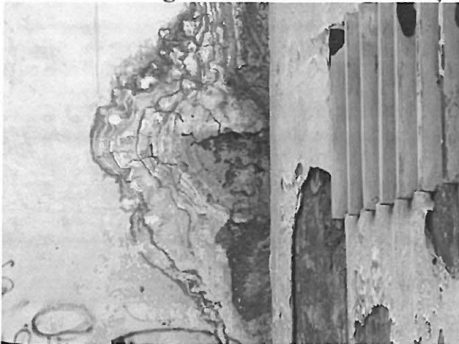
Tencuieli degradate, desprinse și căzute datorită infiltrațiilor de apă
