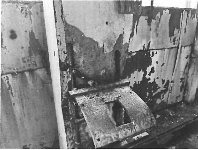
Elemente de acoperiș prefabricate tip FP degradate, fisuri pe două direcții, beton explodat datorită ciclurilor îngheț-dezghet, armături expuse și ruginite
