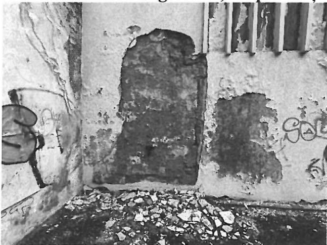
Tencuieli degradate, desprinse și căzute datorită infiltrațiilor de apă
