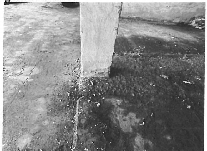
Stâlp central degradat la bază
