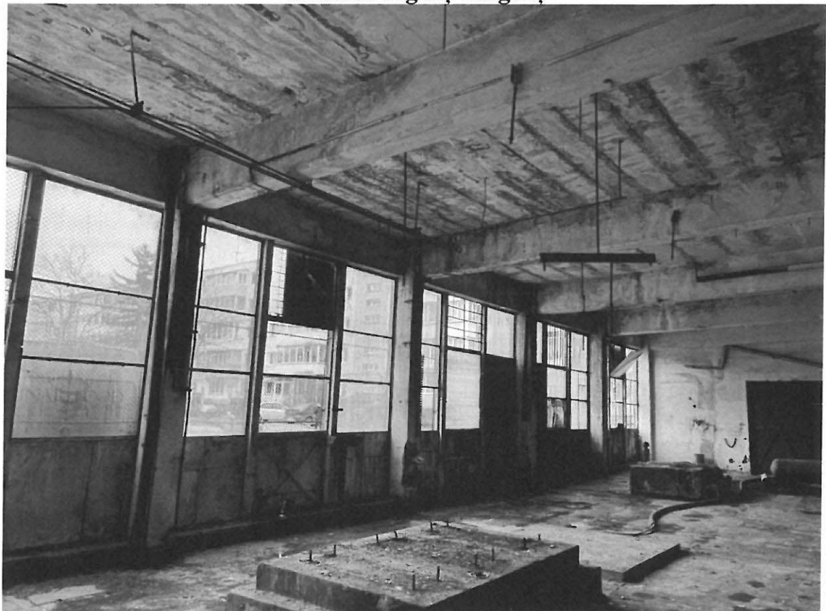
Elemente de acoperiș prefabricate tip FP deteriorate de infiltrațiile de apă și ciclurile îngheț-dezghet
