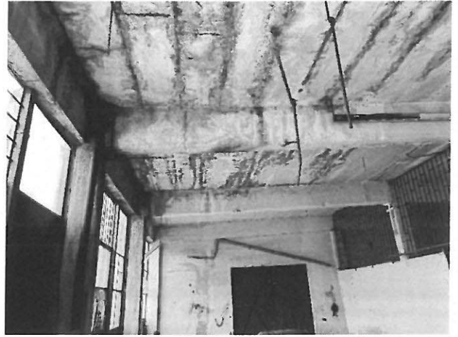
Elemente de acoperiș prefabricate tip FP degradate, fisuri pe două direcții, beton explodat datorită ciclurilor îngheț-dezghet, armături expuse și ruginite
