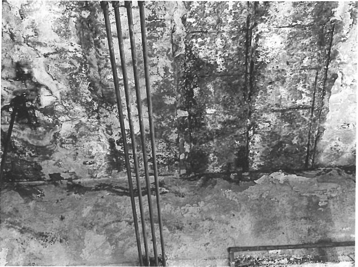
Infiltrații de apă prin coșurile de fum, cărămizi explodate, tencuieli desprinse, căzute
