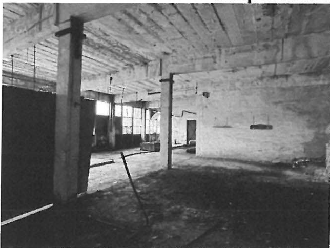
Stâlp central degradat la bază
